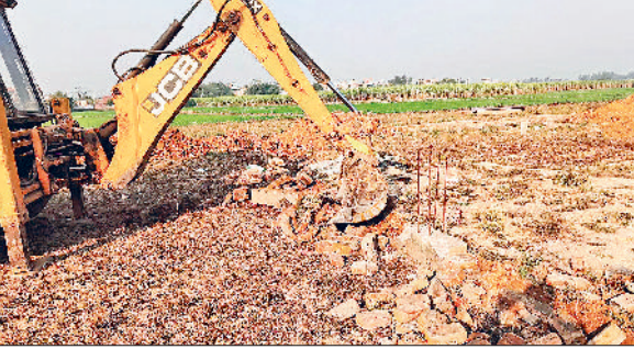
अंबाला। अवैध कॉलोनी में हुए निर्माणों को ढहाती जेसीबी। फोटो: हरिभूमि
